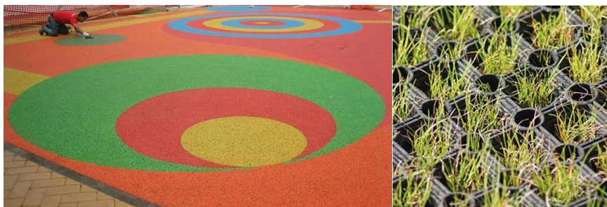
Esempio di pavimentazioni antitrauma in gomma colata colorata e moduli alveolari in gomma intasati con terra e inerbiti
